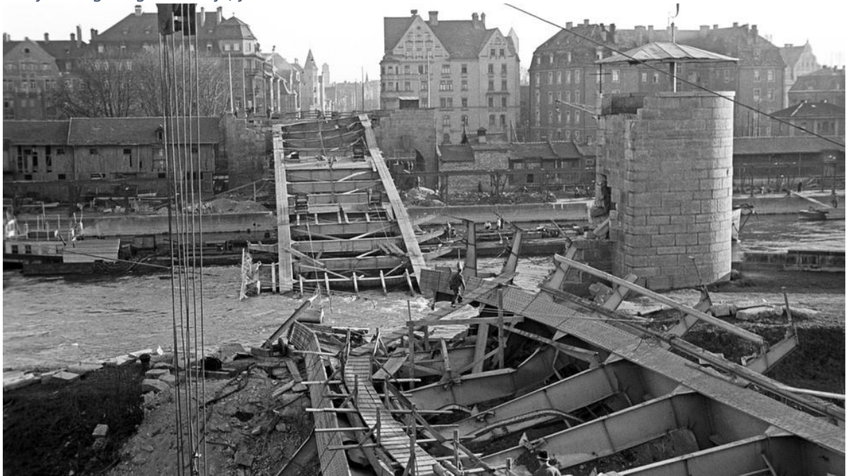
Die zerstörte Nibelungenbrücke in Regensburg, März 1946. © Christoph Lang / Stadt Regensburg
