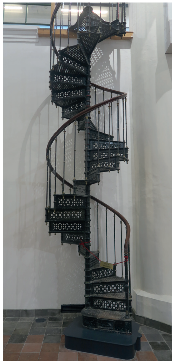
De stalen trap van de publieksruimte naar de eerste verdieping.
