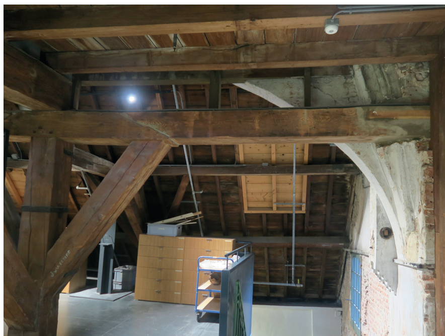
Houten dakspanten in het zicht op de zolderverdieping.
