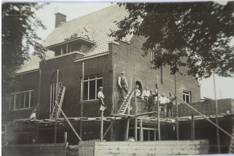
Emmastraat 16 in aanbouw (omstreeks 1936?)
