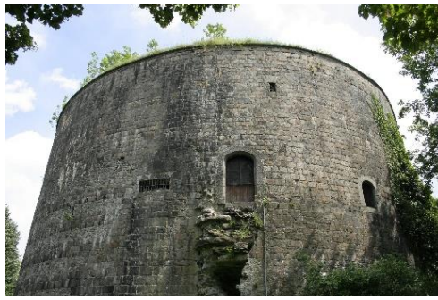
Resterende "Tour Henri VIII" met muren van acht meter dikte.
