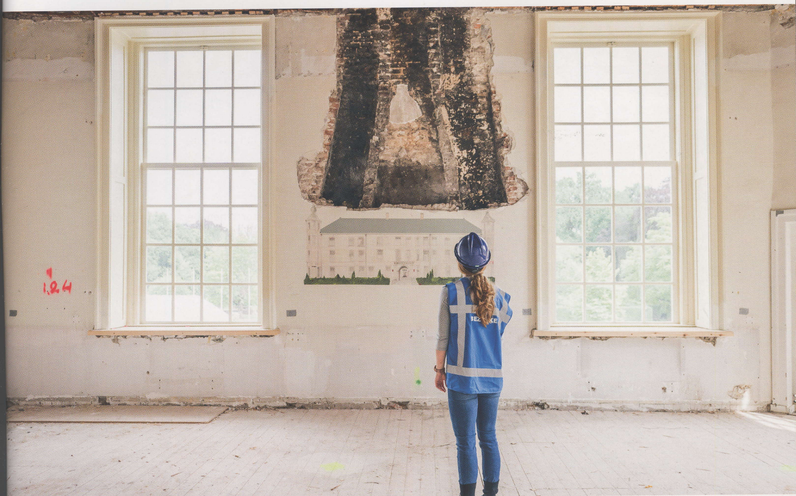
Nieuwe schouwen worden geplaatst op de plek waar ze vroeger hebben gestaan.
