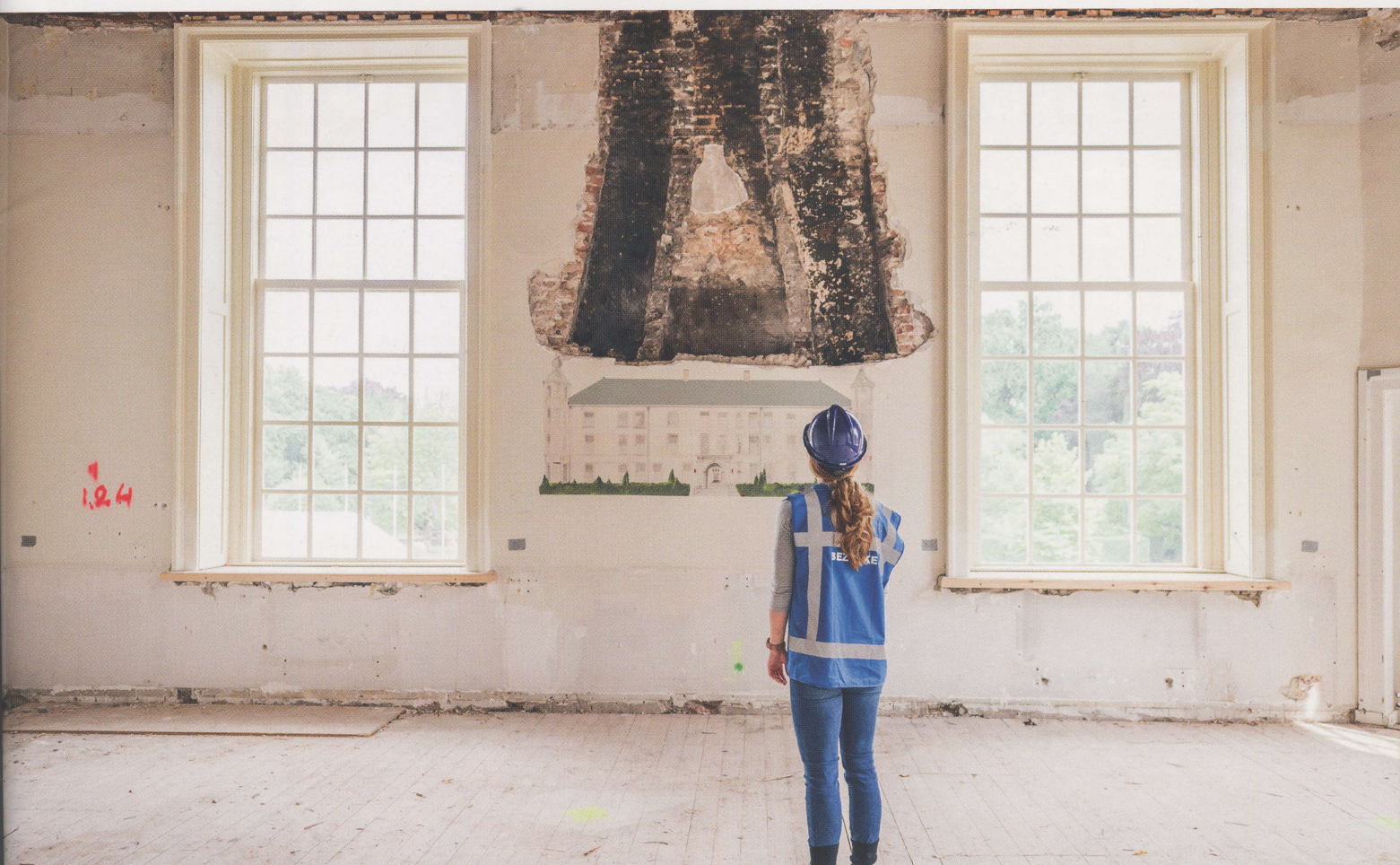
Nieuwe schouwen worden geplaatst op de plek waar ze vroeger hebben gestaan.
