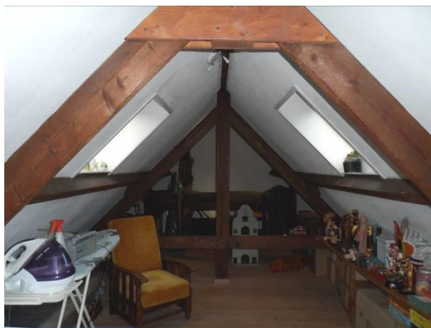
De spantconstructie op zolder.
