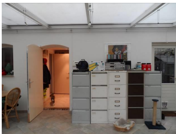
De oorspronkelijke buitenmuur in de serre.
