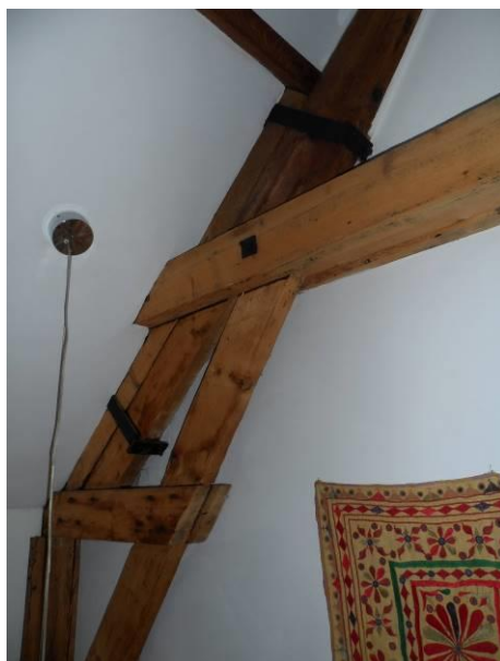
Spantconstructie in het trapportaal.
