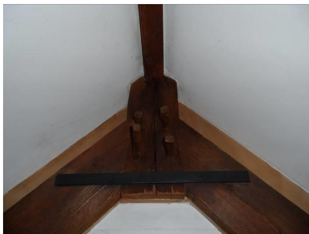
Versteving van een van de spanten op zolder.
