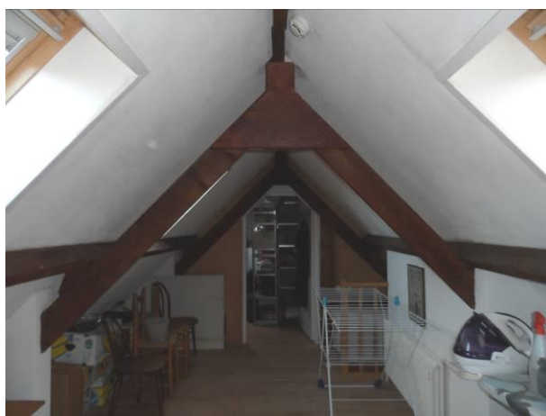
De spantconstructie op zolder.
