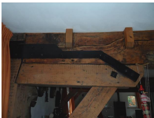
Moerbalk met versteving op de eerste verdieping.
