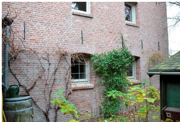
Begane grond niveau van de achtergevel.
